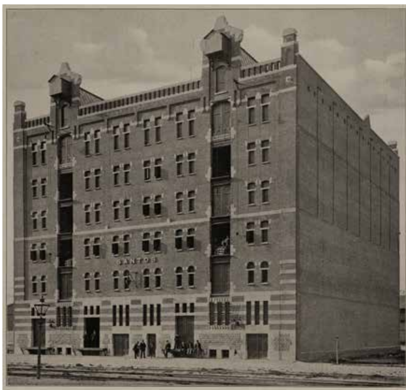
Pakhuis Santos, Rotterdam | Ontworpen door de architecten J.P. Stok & J.J. Kanterers | Foto: Graafland, 1917
